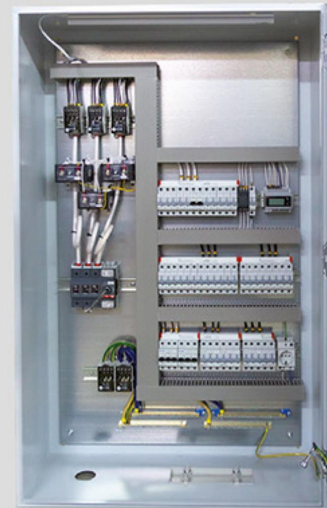
**ШУН** – шкафы управления насосами. Предназначены для автоматизации работы насосных систем, дистанционного управления насосами, контроля уровня воды в скважинах. Чаще всего шкафы управления насосами используются на станциях водоподготовки, в канализационных насосных, на производствах, занятых переработкой воды.
