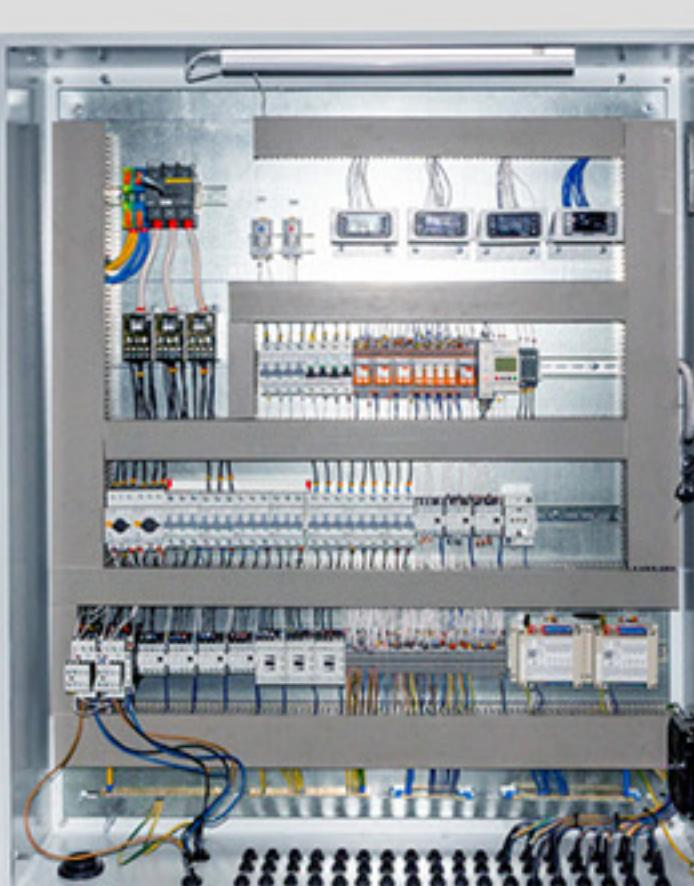
**ШУП** – шкафы управления технологическим оборудованием могут иметь самый широкий спектр применений от простого управления конвейерами до комплексного управления всем производственным комплексом.
